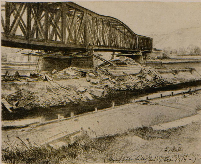
Wiederherstellung der gesprengten Brücke in Anseremme
